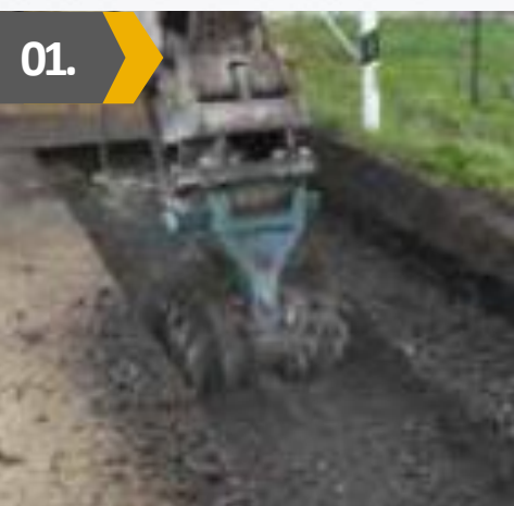
01. Excavación de Zanjas y Canalizaciones
